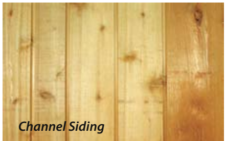
V-Joint Tongue & Groove
